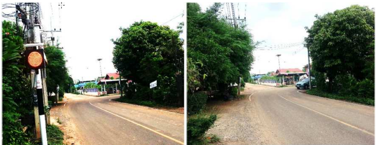
หลังดำเนินการ อบต.หนองชัยศรี สนับสนุนงบประมาณติดตั้งเสาสัญญาณไฟเตือนโซล่าเซลล์ก่อนถึงทางโค้ง และแนะนำให้ตัดกิ่งไม้ (ต้นมะม่วง) เพื่อให้โล่งสามารถมองเห็นรถที่วิ่งมาจากทางขวา ซึ่งเป็นทางหลัก
