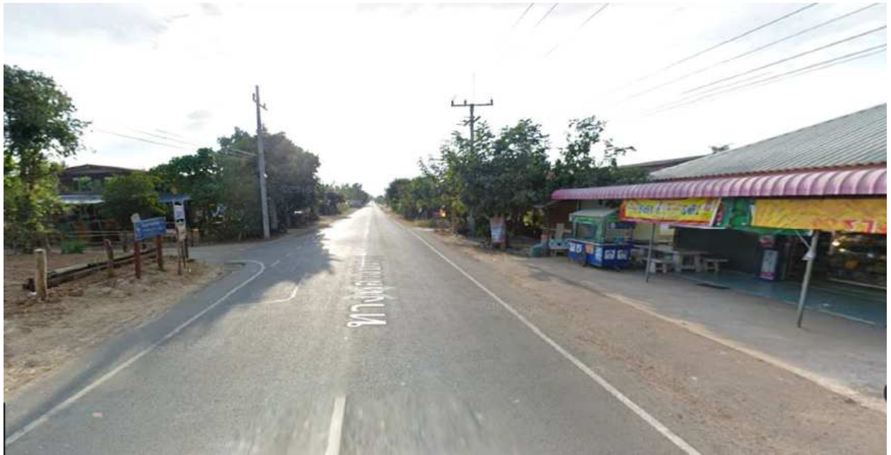
ก่อนดำเนินการ เป็นสามแยกมุมอับ ทางลาดเอียงลง
